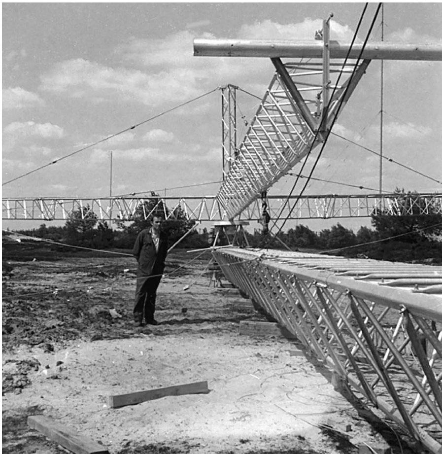
Opbouw van de LogPer. De pylonenmasten vormen de draagconstructie, waartussen de LogPer antennedraden werden gespannen.
